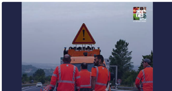
Plusieurs chantiers routiers lancés cet été
