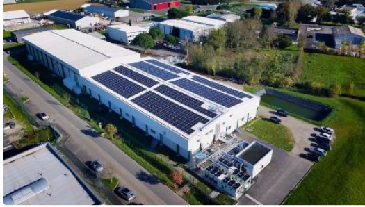
Gimbert surgelé amorce une transformation profonde pour soutenir son activité industrielle
