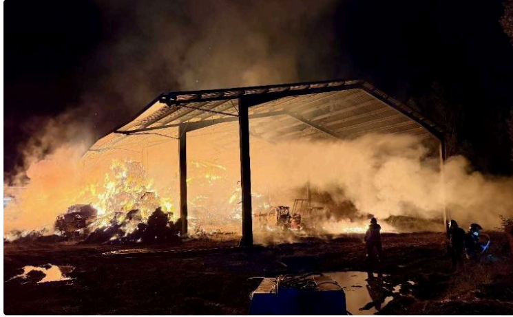
Un incendie détruit un hangar de 1 600 m2 et ses panneaux photovoltaïques,
