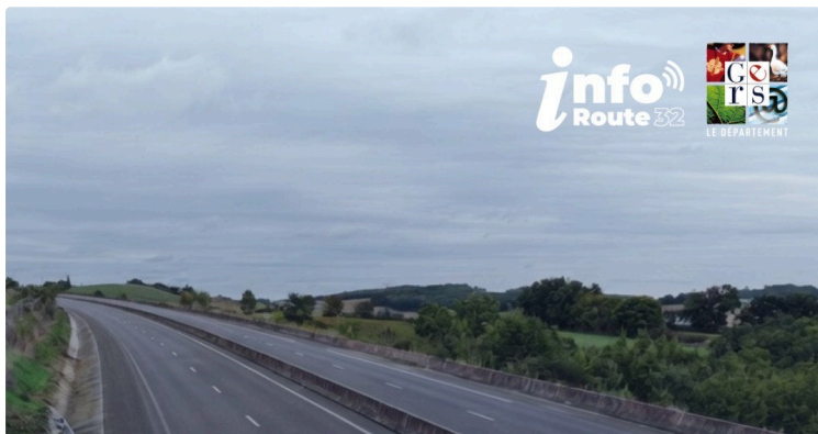
Des travaux de rénovation prévus sur la RD1124
