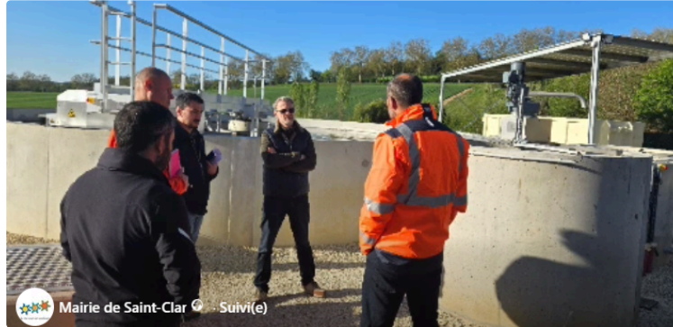
Nouvelle station d'épuration de Saint-Clar
