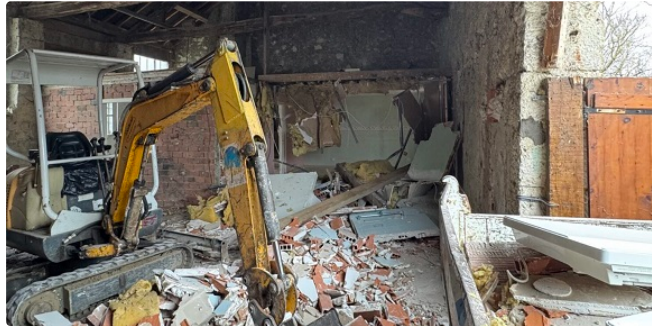
Début des travaux à la maison Nascimbene
