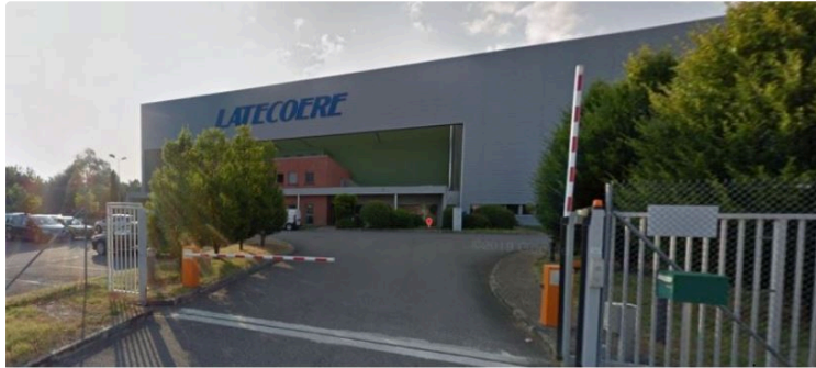
Suite à une fuite de gaz à Latécoère, une centaine de personnes évacuées
