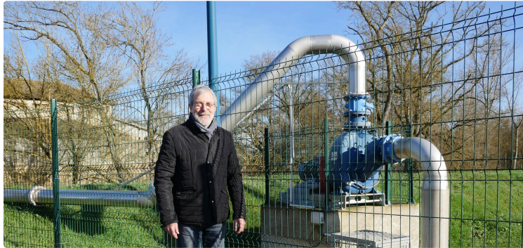
Au sec grâce à la pompe !
