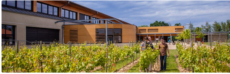
Plus de 15 M€ de la Région pour la rénovation énergétique et la modernisation des lycées d'Occitanie
