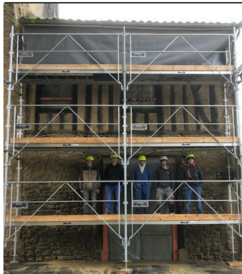
renovation clos 1.jpg
