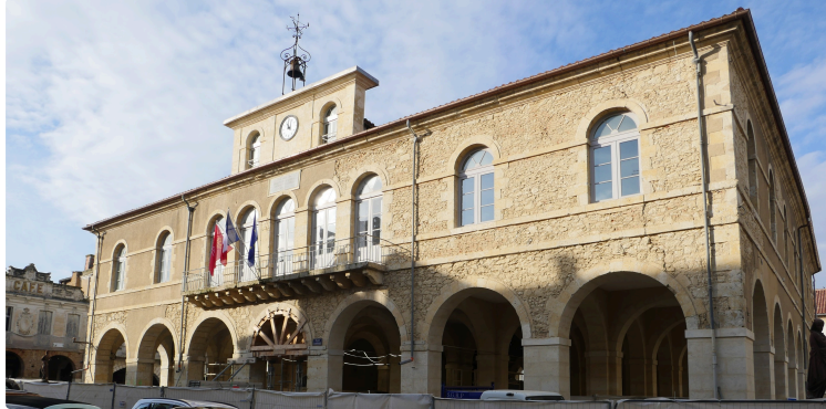
Travaux hôtel de ville
