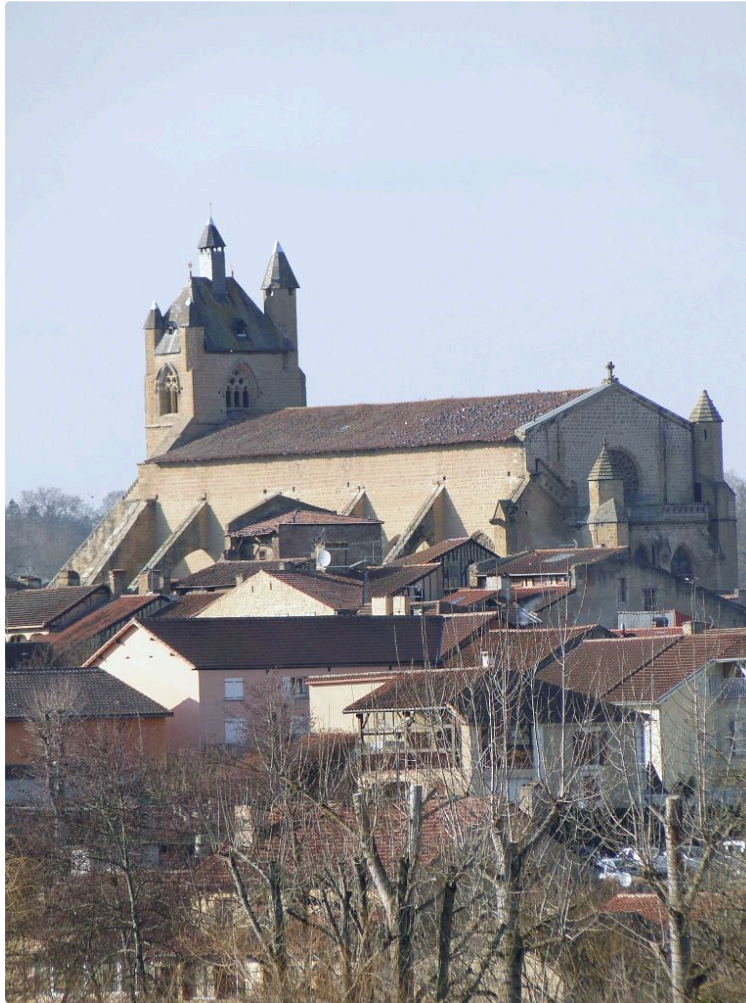
Annonces paroissiales du 24 janvier au 1er février 2026
