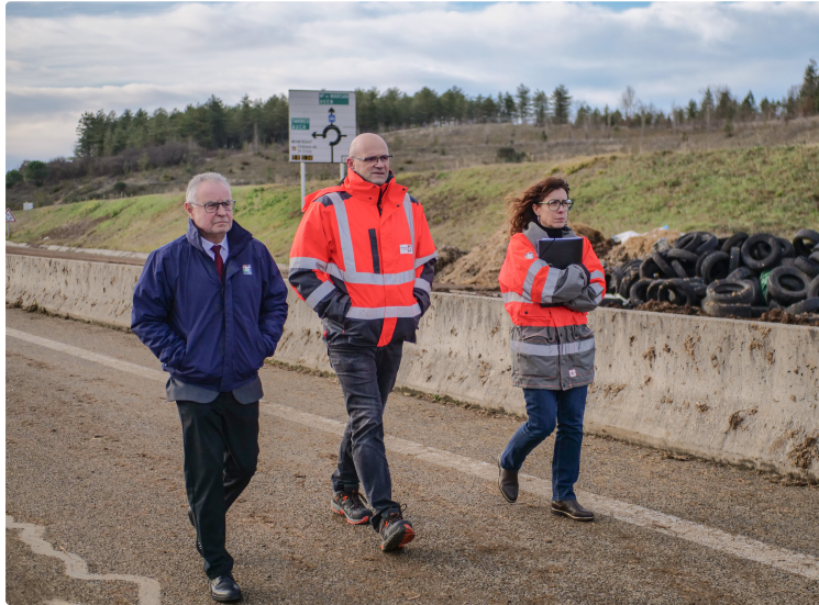
Dégradations routières dans le Gers : des travaux lourds engagés cette semaine par le Département
