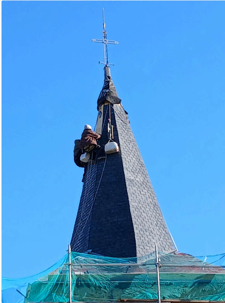
Charpentiers cordistes, ils défient la météo
