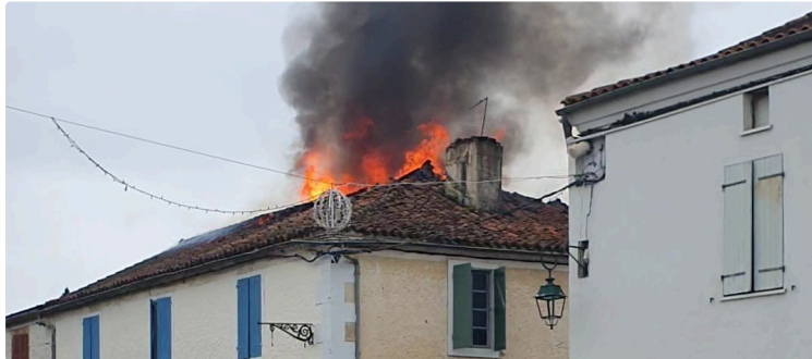
Important incendie à Miélan
