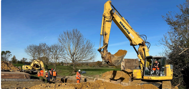
Le premier acte de la rénovation du réseau d'assainissement de la commune de Miélan.
