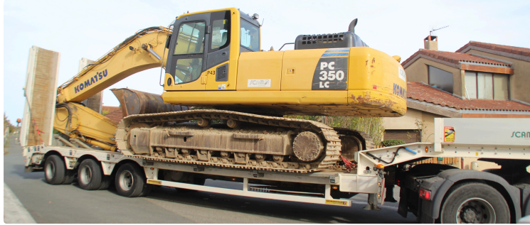
Mise aux normes du réseau d'assainissement
