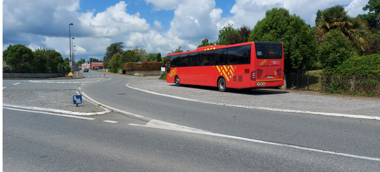
Création de deux arrêts de bus sécurisés
