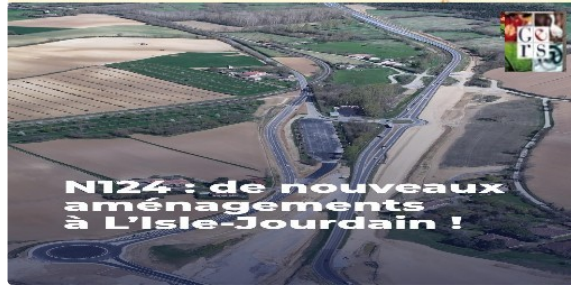
Travaux N124 : une nouvelle étape
