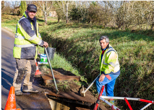
Francis et Sébastien Brunet en train de refermer un puits
