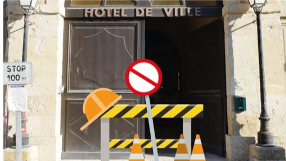
Travaux sur la porte de l'entrée principale
