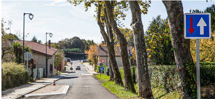
Fin des travaux à Laujuzan
