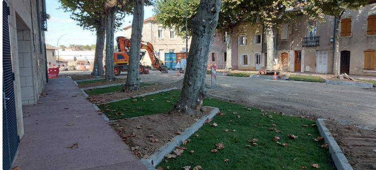
Clap de fin pour les travaux place Crespin
