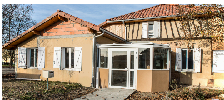
Façade du bâtiment du Clan, qui a été rénové en 2016.
