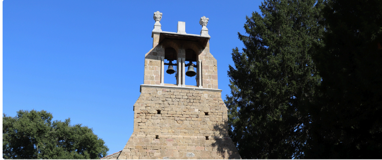
L'église Saint Pierre rénoverée
