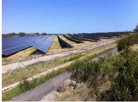
Face à un projet photovoltaïque de grande envergure
