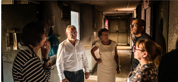
Incendie à l'Ehpad Saint-Jacques
