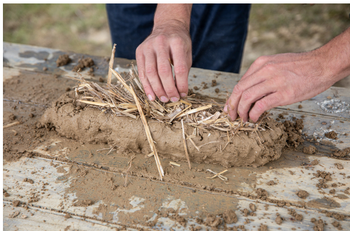
La paille de blé (à défaut de paille de seigle) est incorporée à l'argile
