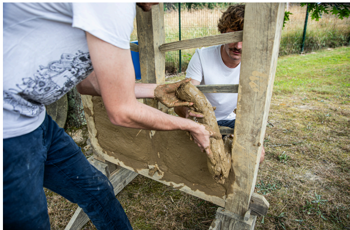
Le pain de torchis est posé sur le panneau
