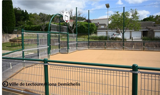
Travaux de finition du City-Stade
