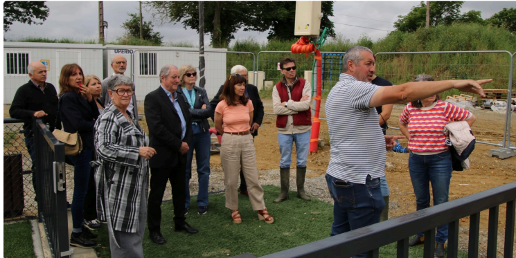
Les élus sur le chantier du nouveau stade
