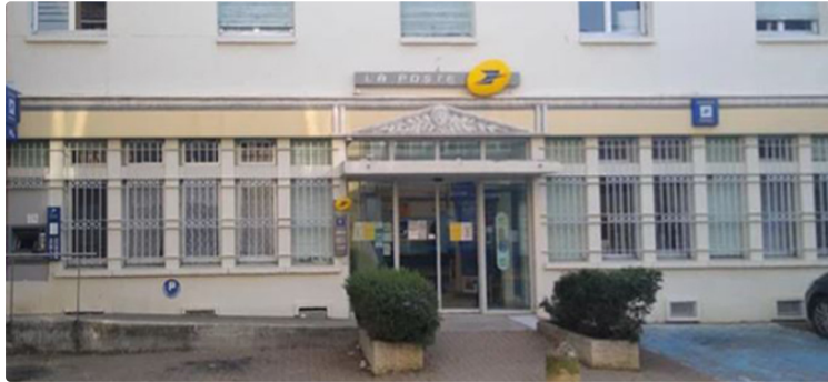
La Poste fermée pour travaux
