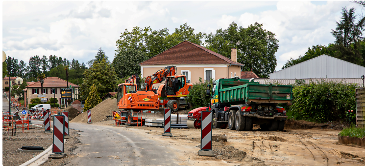
Réponse du maire de Laujuzan à l'article sur les travaux au village
