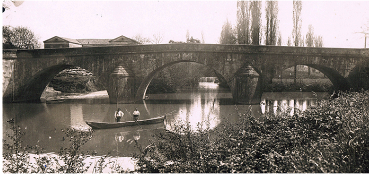
Histoire locale : les deux ponts sur la Baïse
