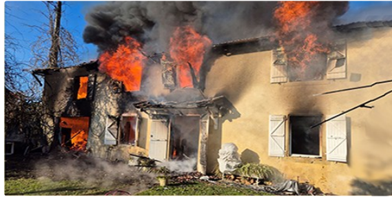
Une maison détruite par un violent incendie
