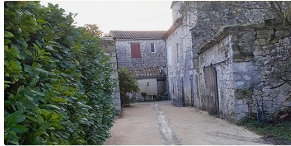
Des travaux de voirie s'achèvent
