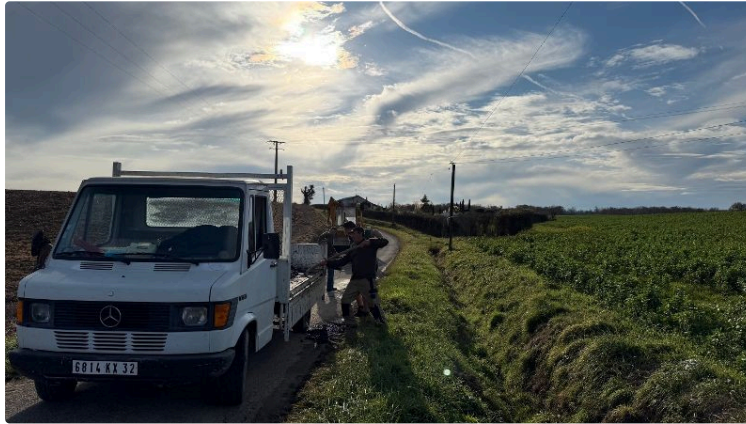
Les travaux de voirie 2024 sont terminés
