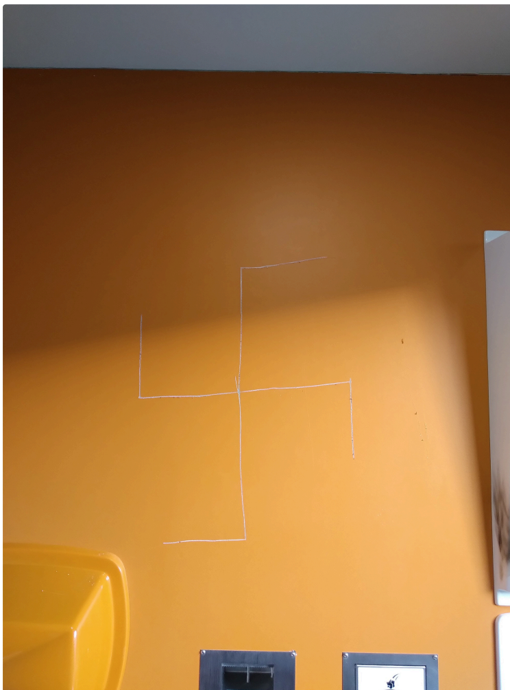
Dégradations intolérables dans les sanitaires publics de la Place Gambetta.
