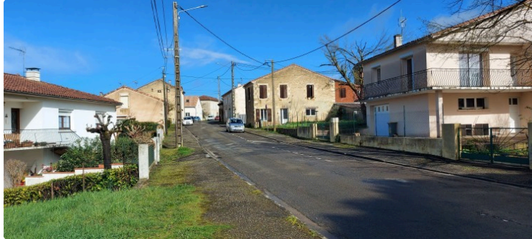
Les travaux de l'avenue des Pyrénées vont débuter fin janvier !
