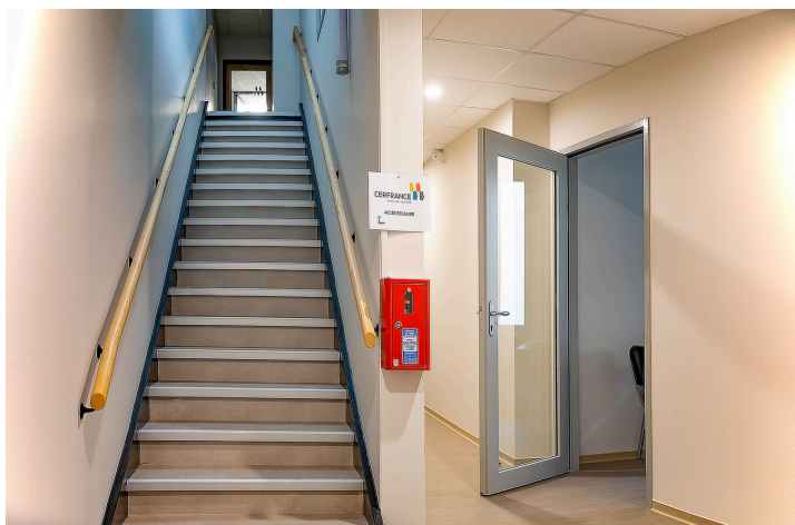
Escalier pour le 1er étage
