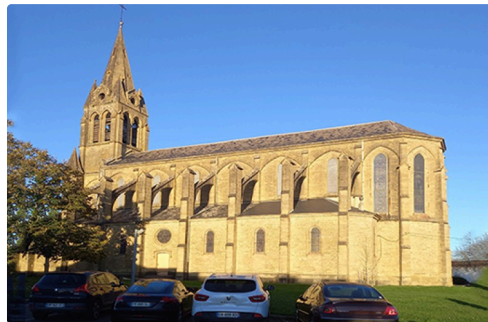
plaisance eglise toiture eglise (002).jpg
