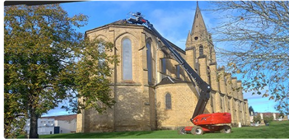
Tout beau tout neuf le toit de l'église
