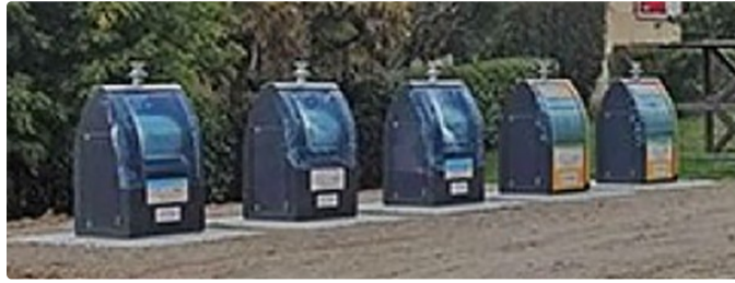
Fin du « porte à porte de la collecte des déchets ménagers »
