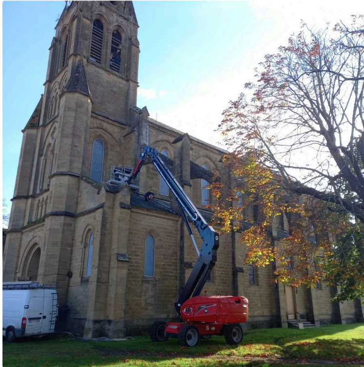
Des travaux sur le toit de l'église
