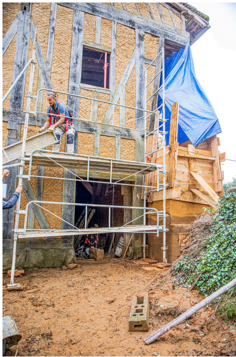
Travaux sur la façade nord en 2021
