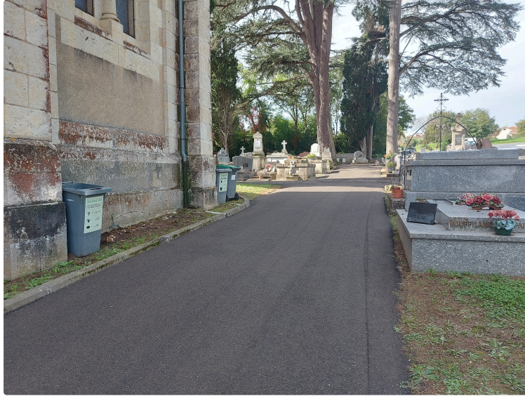
Les travaux de réfection au cimetière bientôt terminés
