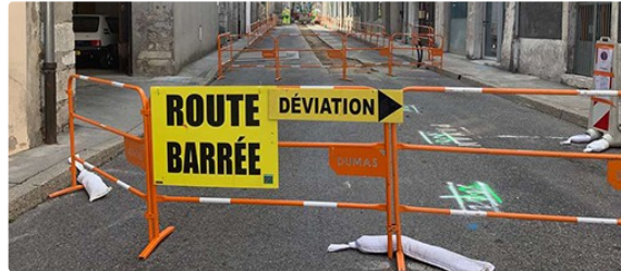
Travaux : Restriction de circulation en ville
