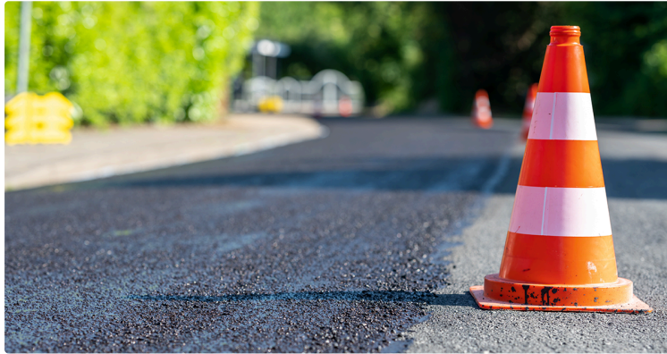
Travaux : Le Département informe les usagers de la N21 des perturbations de trafic à compter du 30/09.
