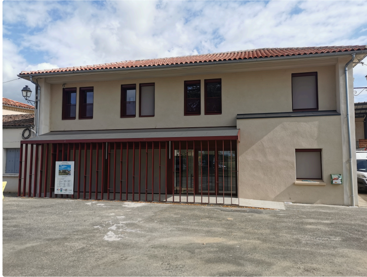
Nouveaux locaux pour la Ludothèque et l'Espace Ressources Val de Gers à Seissan
