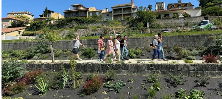
Jardin Deu Houtanèr : visite de chantier
