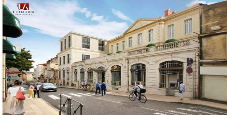
La Poste de la rue Gambetta en travaux
