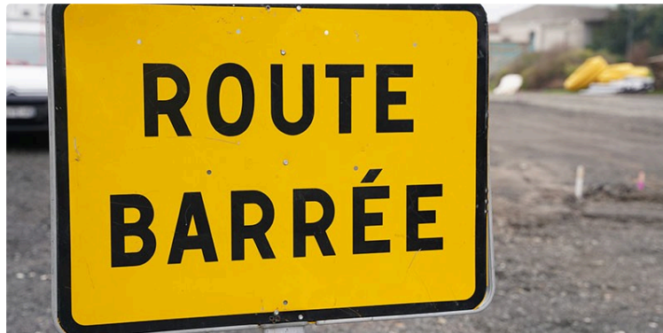
Circulation : travaux sur la N124 à Dému du 8 au 17 juillet 2024
